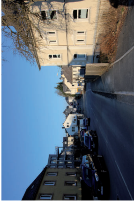
Gehwegsituation Bad Stebener Straße. © transform
